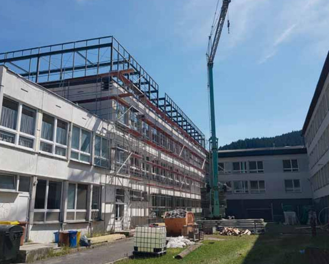
Nadstavba na Základnej škole Klačno.
