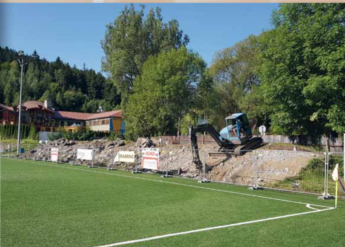
Výstavba tribúny pri umelom trávniku.
