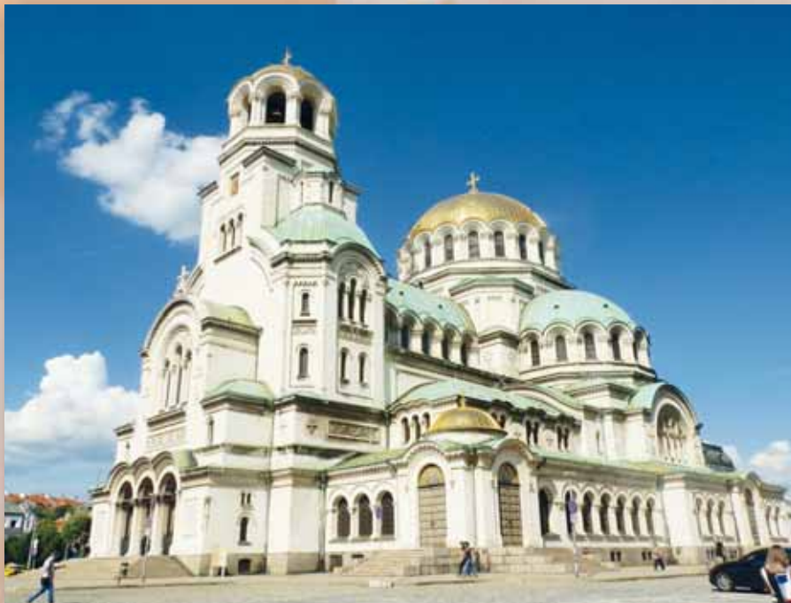
Chrám svätého Alexandra Nevského je zrejme najznámejšou stavbou v hlavnom meste Bulharska. Ide o druhý najväčší pravoslávny chrám na Balkáne. Jeho výstavba začala v roku 1882 a trvala tridsať rokov. Úchvatné dielo bolo postavené na počesť ruských vojakov, ktorí v rokoch 1877 - 1878 prišli o život pri oslobodzovaní Bulharska spod Tureckej nadvlády. Foto: Ján Kmeť
