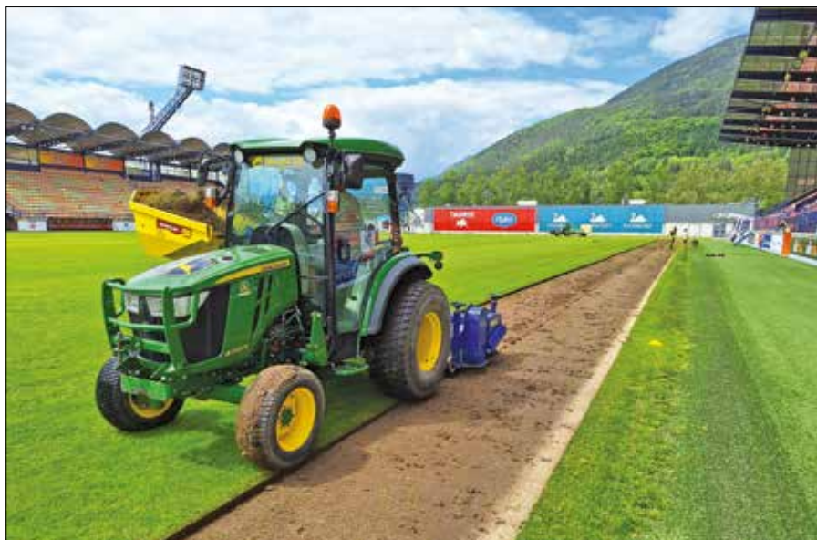
Odfrezovanie pôvodného trávnika systémom KORO.
